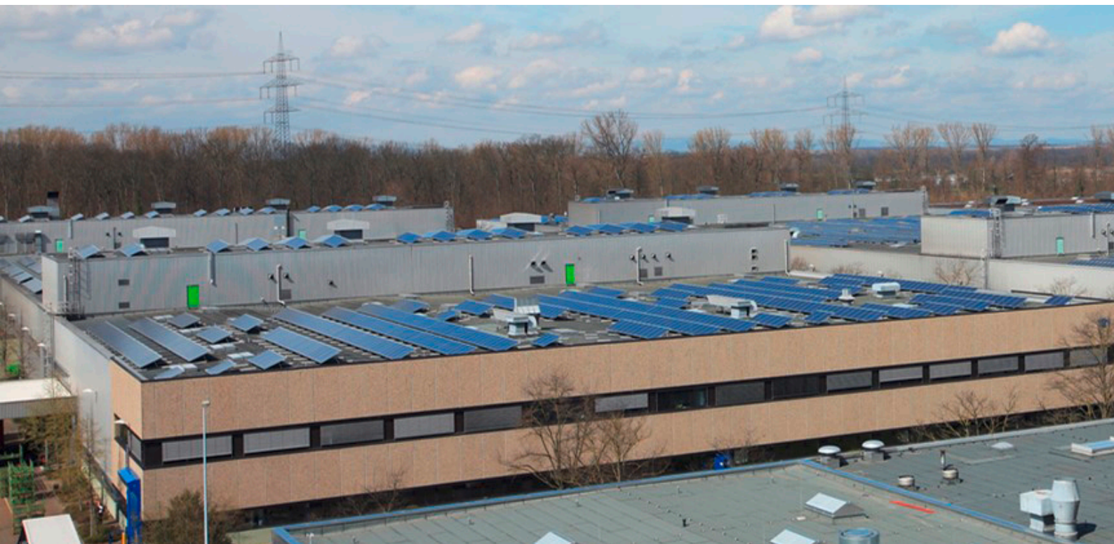
Photovoltaik-Anlage auf Dächern am Standort Rastatt
