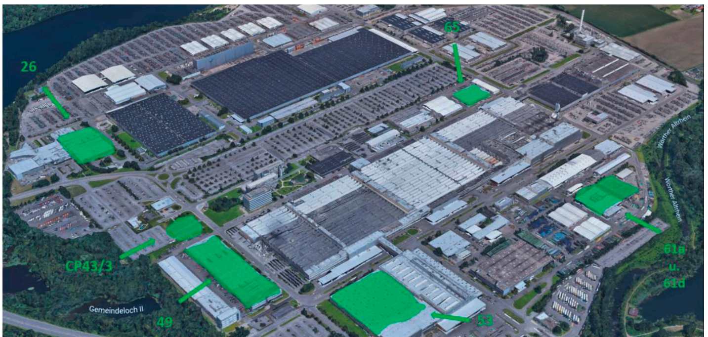
Abb. 29: Dachflächen zur Installation von PV-Anlagen
